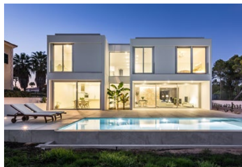
Eficiencia energética de las instalaciones de iluminación.
